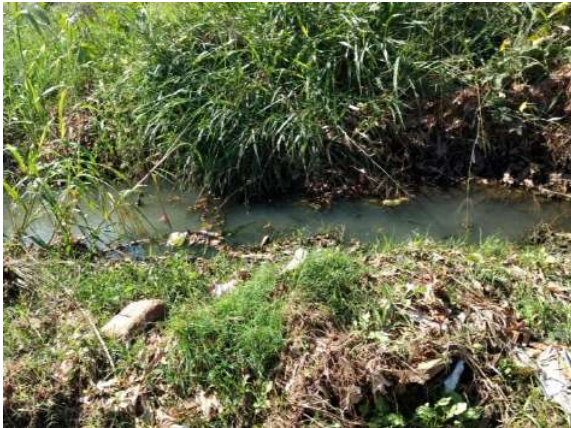
Foto 3.49 – Esgoto transbordando devido ao emissário rompido na região da voçoroca
