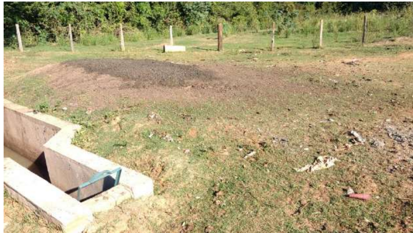
Foto 3.40 - Vista geral – Resíduos retirados da caixa de areia (ETE Pau d'Alho)
