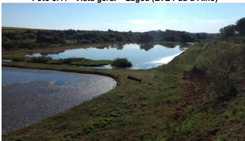
Foto 3.42 - Vista geral – Lagoa (ETE Pau d'Alho)
