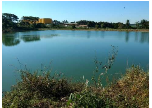
Foto 3.37 – Vista geral – Lagoa (ETE Baixão)
