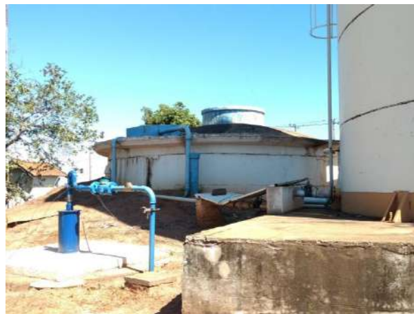
Foto 3.2 - Identificação do Poço: P02
