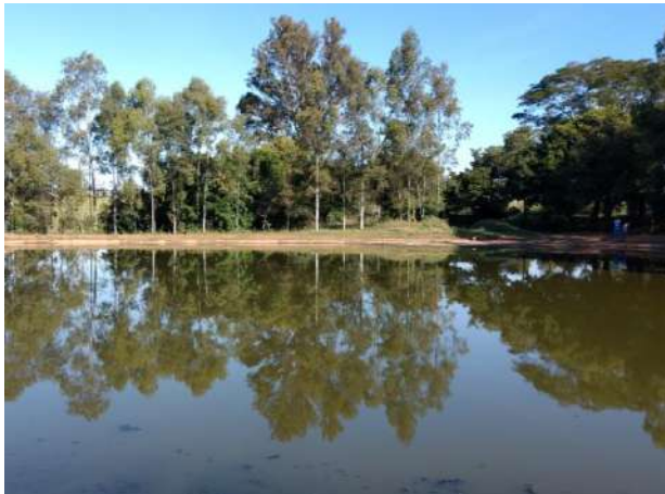
Foto 3.36 - Vista geral – Lagoa (ETE Baixão)
