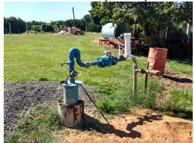
Foto 3.16 - Identificação do Poço: P09 – Álvora
