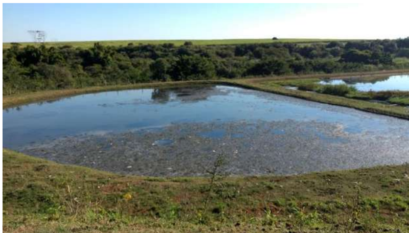
Foto 3.41 - Vista geral – Lagoa (ETE Pau d'Alho)
