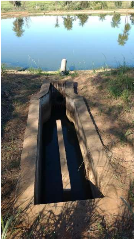
Foto 6.34 - Entrada ETE Baixão
