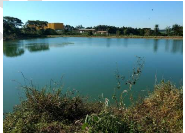
Foto 6.37 – Vista geral – Lagoa (ETE Baixão)
