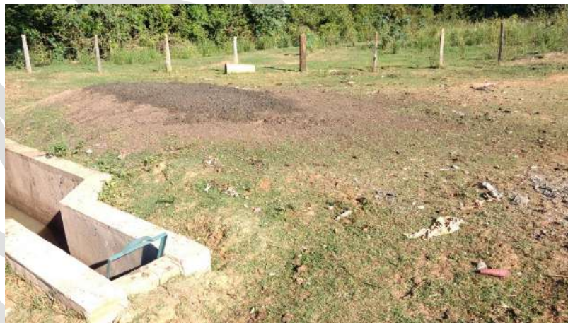
Foto 6.40 - Vista geral - Resíduos retirados da caixa de areia (ETE Pau d'Alho)
