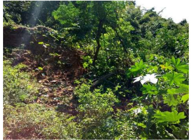
Foto 6.48 – Vista parcial da voçoroca
