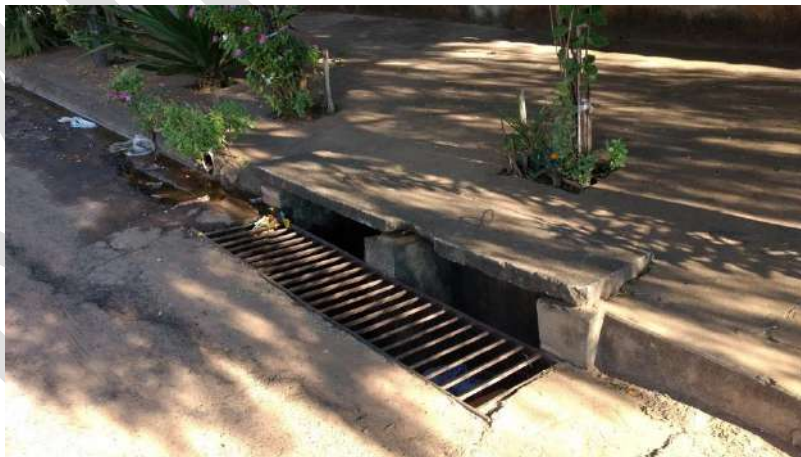
Foto 6.43 – Cruzamento da Rua Moacir Costa e Av. Joaquim Afonso
