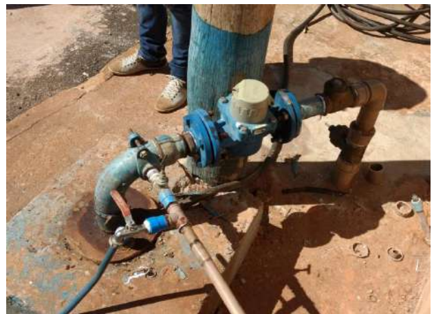
Foto 6.6 - Identificação do Poço: P08
