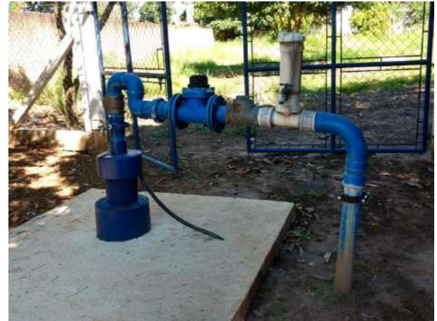
Foto 6.8 - Identificação do Poço: P11
