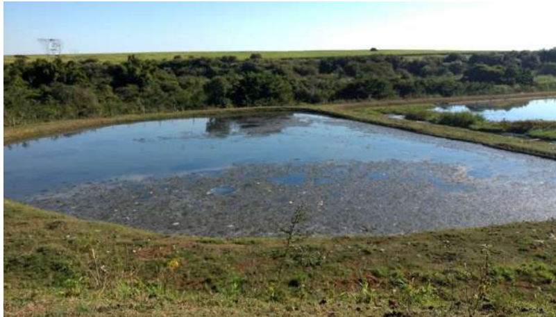
Foto 6.41 - Vista geral – Lagoa (ETE Pau d'Alho)
