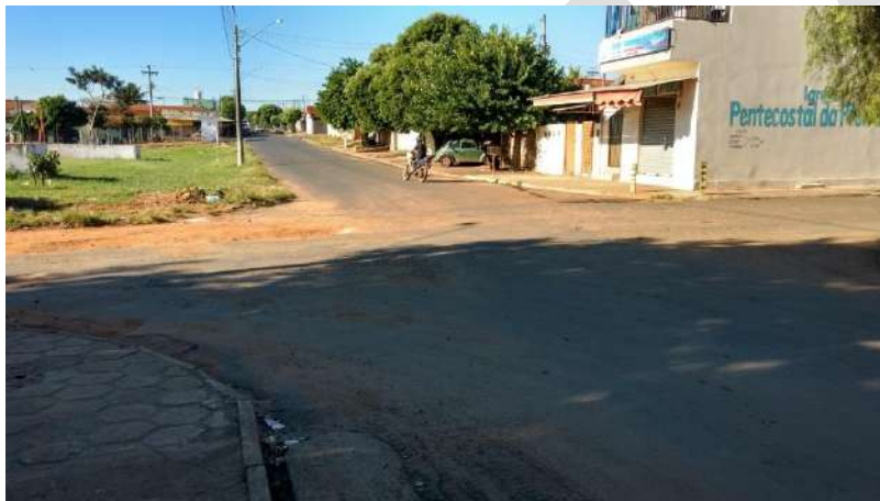
Foto 6.45 – Cruzamento da Rua Moacir Costa e Av. Joaquim Afonso
