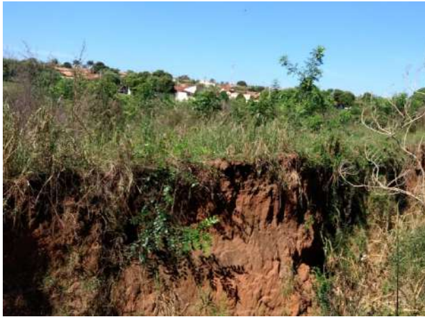
Foto 6.47 – Vista parcial da voçoroca
