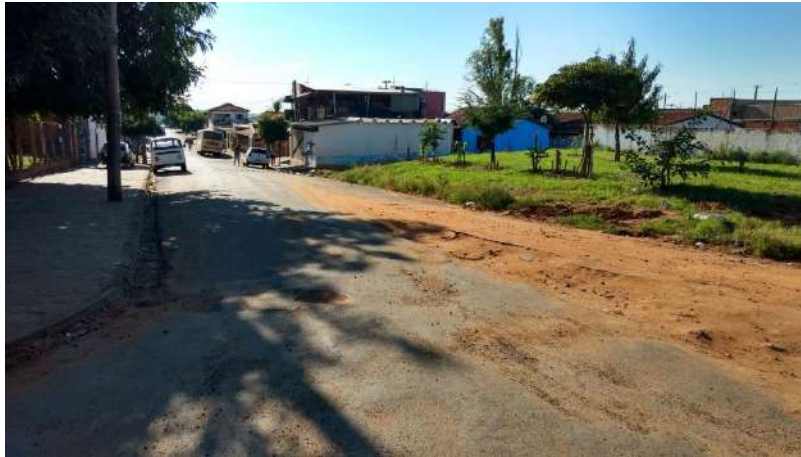
Foto 6.44 – Cruzamento da Rua Moacir Costa e Av. Joaquim Afonso
