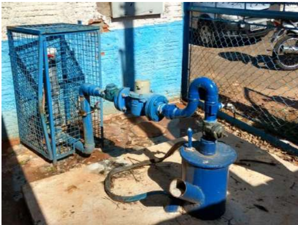
Foto 6.3 - Identificação do Poço: P04
