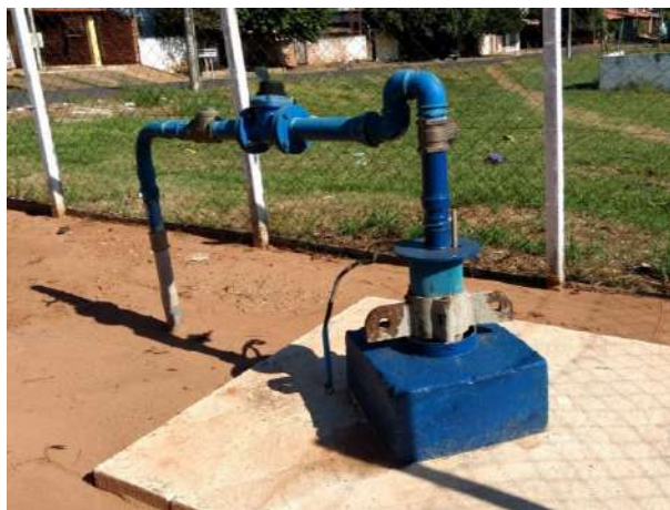
Foto 6.9 - Identificação do Poço: P12
