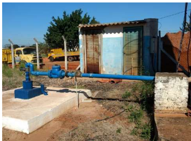
Foto 6.12 - Identificação do Poço: P15
