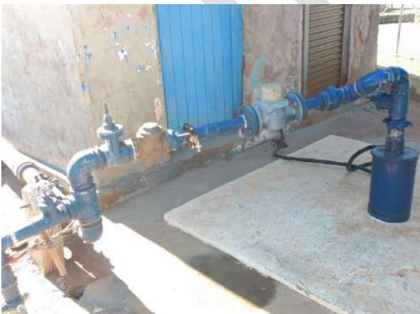
Foto 6.5 - Identificação do Poço: P07
