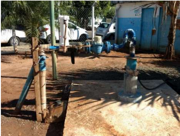
Foto 6.7 - Identificação do Poço: P10
