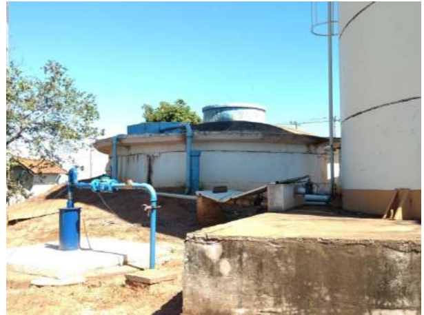
Foto 6.2 - Identificação do Poço: P02
