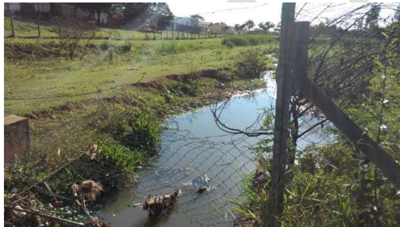
Foto 6.53 – Fim da escada hidráulica – reservatório de retenção
