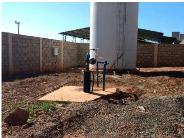
Foto 6.15 - Identificação do Poço: P18
