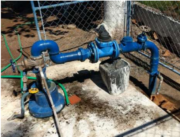
Foto 6.1 - Identificação do Poço: P01
