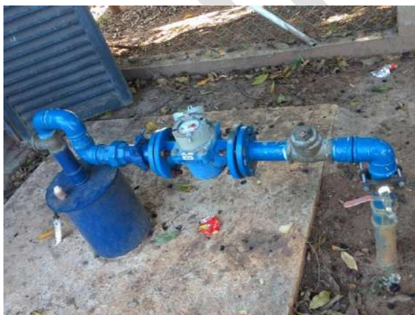
Foto 6.11 - Identificação do Poço: P14
