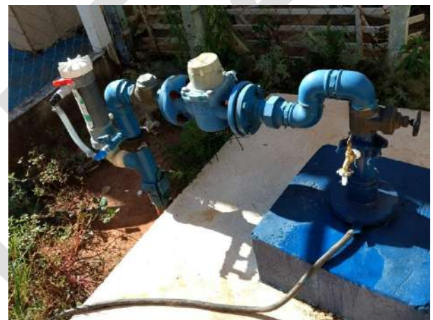
Foto 6.10 - Identificação do Poço: P13
