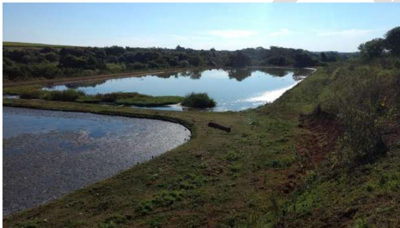
Foto 6.42 - Vista geral – Lagoa (ETE Pau d'Alho)
